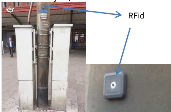
Figuur 1. RFid tag op een bovenleidingmast
